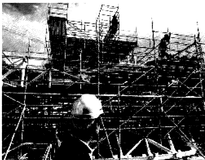
Cantiere edile in una foto di repertorio
